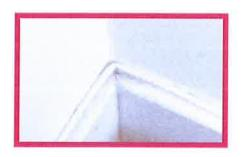
Le câble de fibre optique ne doit pas tourner à angle droit au risque de détériorer ou couper la connexion.
