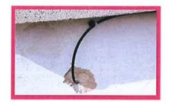
Ce dernier peut s'effectuer par l'intérieur ou l'extérieur, Le technicien est dans l'obligation de remettre en état la zone percée.
