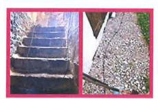
Le câble doit être fixé correctement pour éviter les risques de détérioration et les risques pour les personnes.
