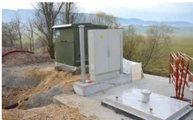
Poste de refoulement des eaux usées vers la station d'épuration de Grand'Combe Châteleu
